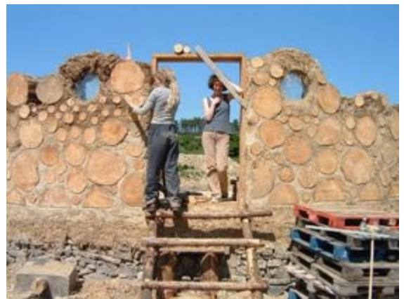
Aprendiendo al hacer: Estudiantes de Kinsale con sus manos a la obra, en plena construcción aplicando la técnica de cob y troncos
